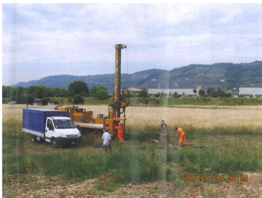
Fig. 1: la esecuzione della trivellazione
